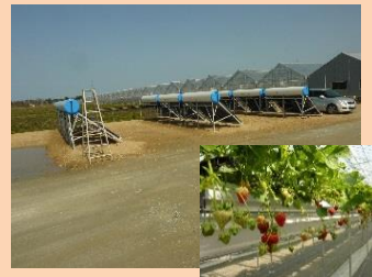
山元町イチゴハウスに9基
